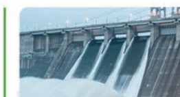
加拿大 水电站管理
